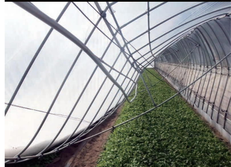
雪の重みで倒壊したハウス (坂井市)
