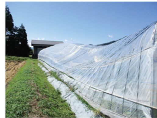
強風で押しつぶされたハウス H 30年 9月 勝山市
