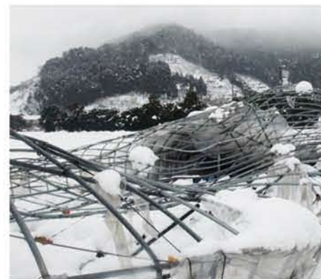
雪害により倒壊した育苗ハウス
