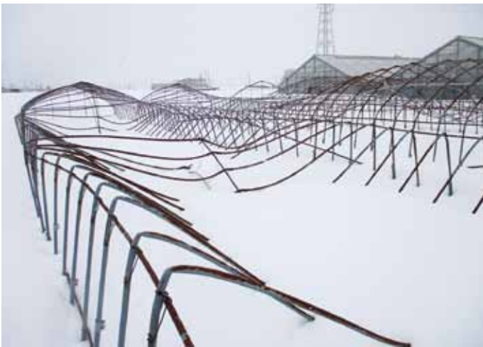
令和 3 年 1 月の大雪で倒壊した未被覆のビニールハウス
