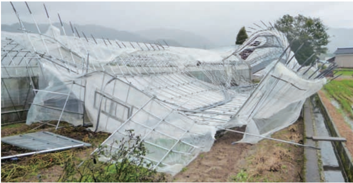
台風による損害を受けたハウス
