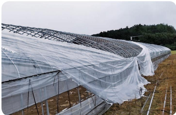
強風によるビニールの破損
